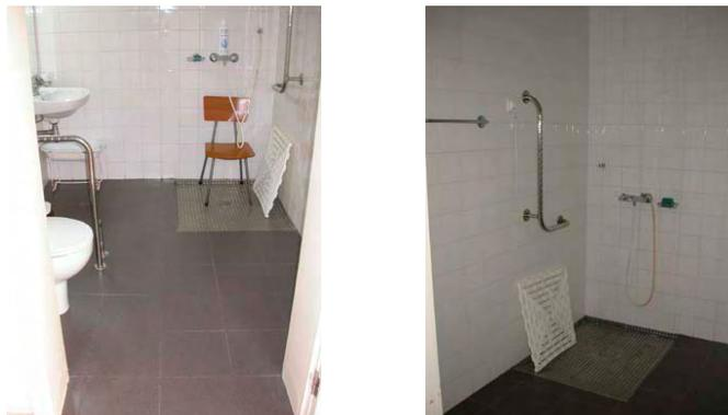
**Fig. 5.29 - Instalações sanitárias com duche - tiveram de ser improvisadas grelhas e cadeiras**
