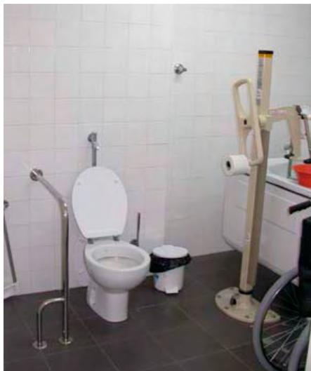
**Fig. 5.35 – No banho assistido existe retrete mas não existe lavatório**
