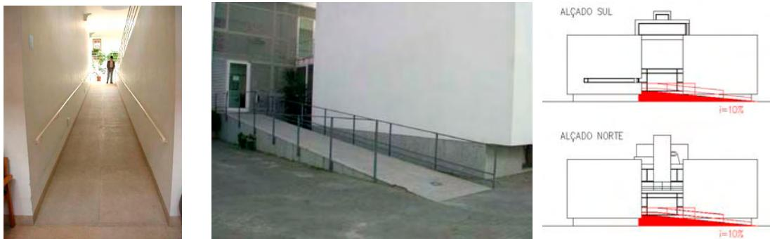
**Fig. 5.37 - Rampa interior e rampas exteriores do edifício**
